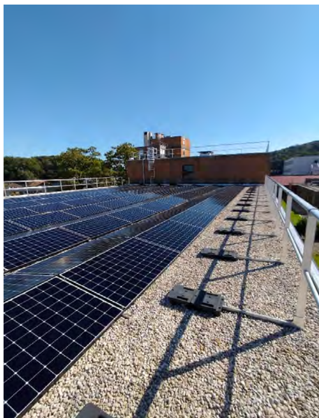
Le toit du lycée de Mouchard (Jura)
