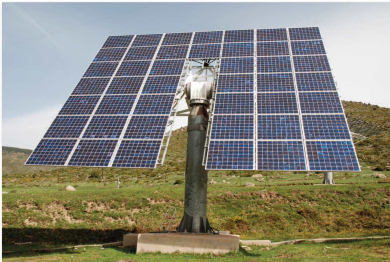
Un héliostat, portique qui oriente les panneaux vers le soleil pour un rayonnement quotidien accru.
