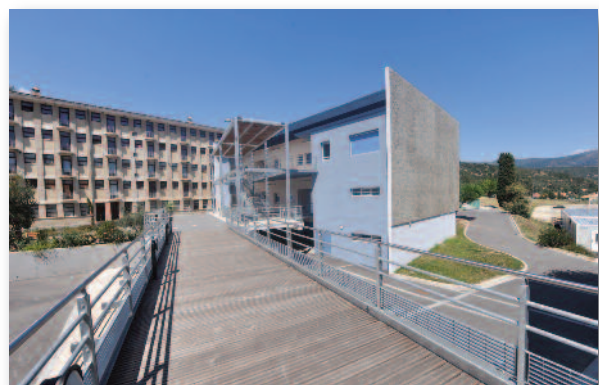
restructuration du lycée C. Renouvier
